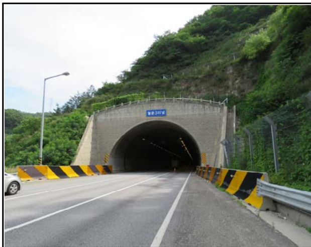
내 용 시점 갱구부 전경
